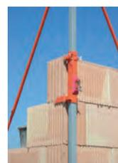
1. Pièce coulissante avec support de cordeau, de niveau et système de réglage d'angle
