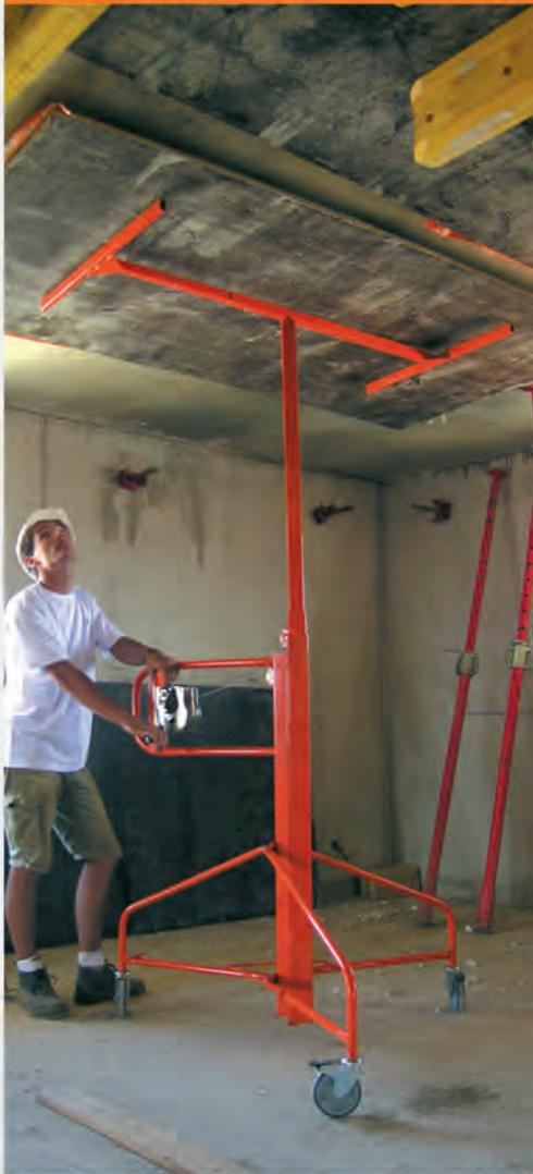
*Permet de descendre facilement et en toute sécurité les planches de coffrage en hauteur*
