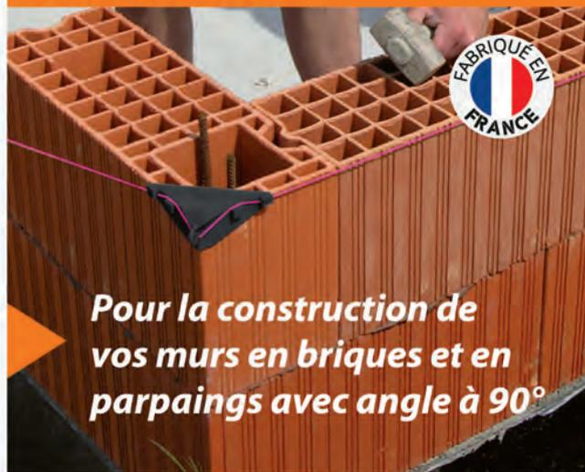
Pour la construction de vos murs en briques et en parpaings avec angle à 90°
