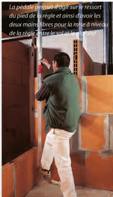
La pédale permet d'agir sur le ressort du pied de la règle et ainsi d'avoir les deux mains libres pour la mise à niveau de la règle entre le sol et le plafond
